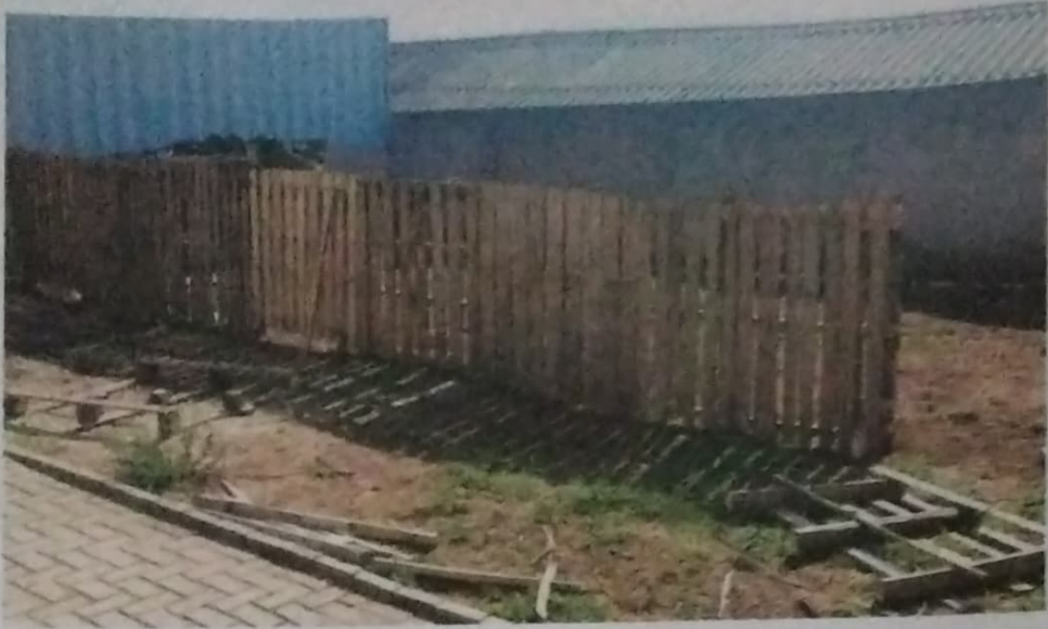
Figura 3: Construção de cercado para proteção do espaço.
