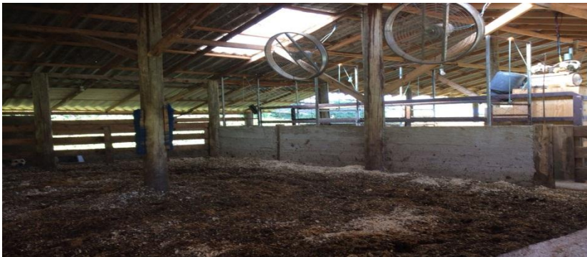
Figura 4: Imagem interna dos barracões com ventiladores e “escovas”.
