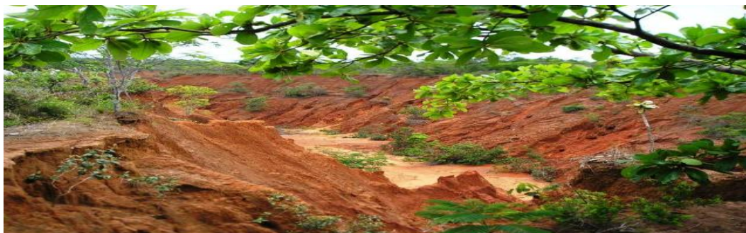
Figura 3 - Erosão em Voçoroca
